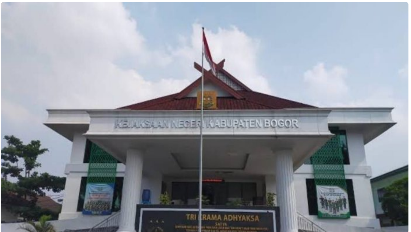
Photo : Gedung Kejari Kabupaten Bogor
