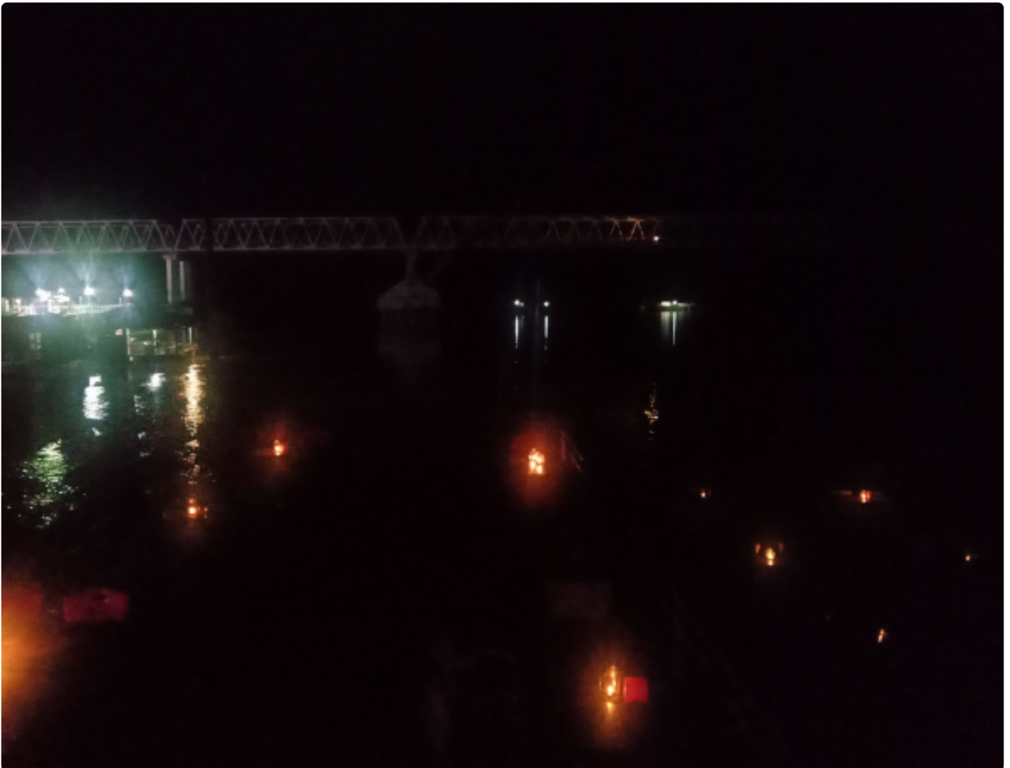
Gambar Jembatan Kahayan Dengan Kondisi Mati, gambar diambil malam tadi 30/7/22 dari kafe terapung Kota Palangka Raya
