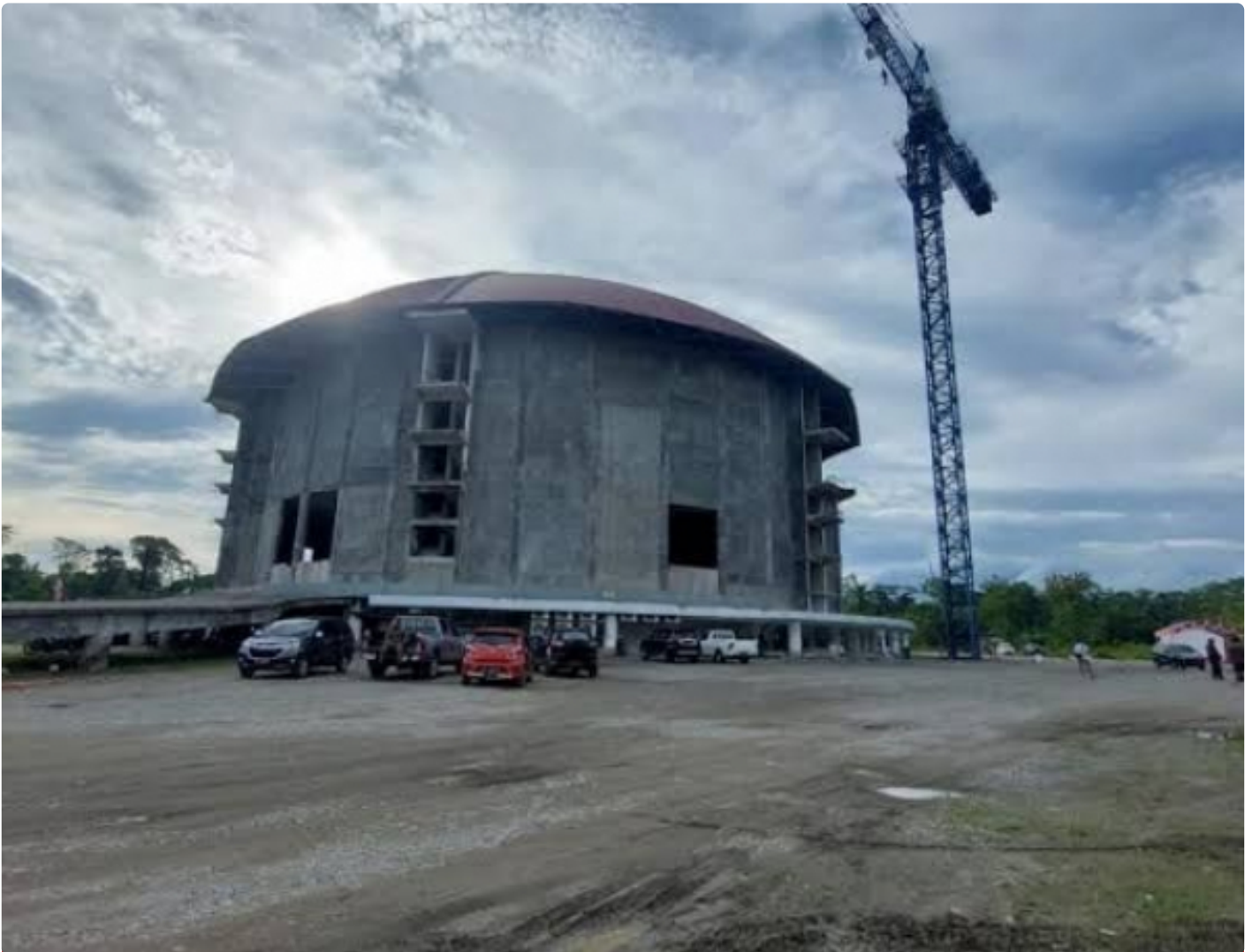
Pembangunan Gereja Kingmi Mile 32
