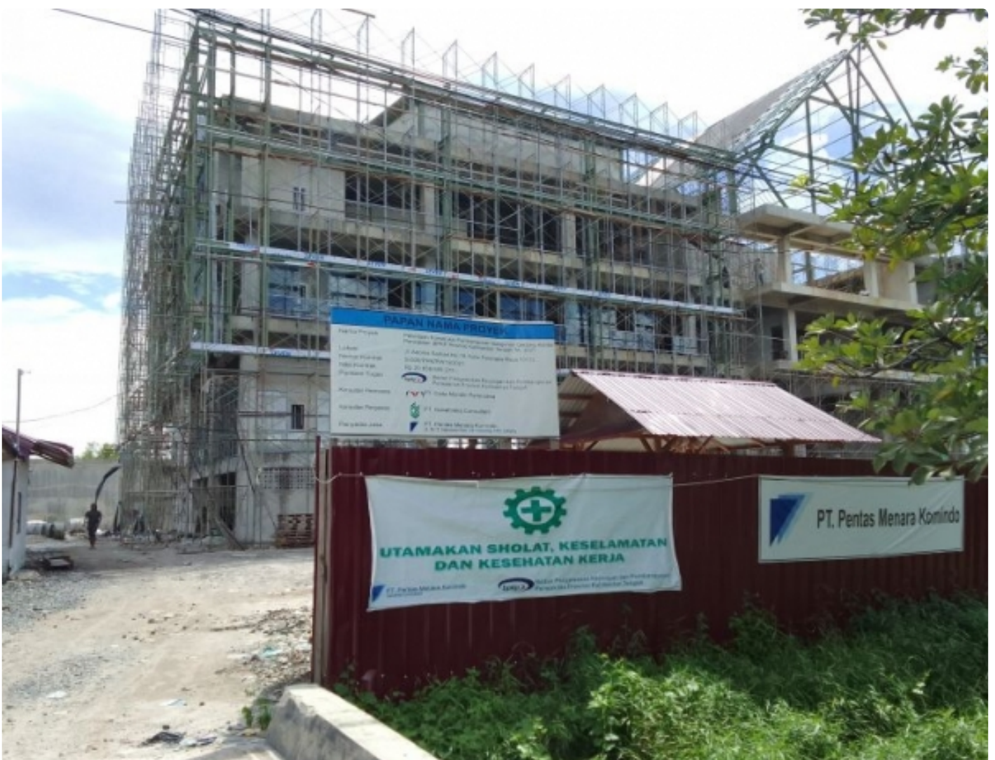
Kantor BPKP yang baru, berdiri megah di jalan Adonis Samad Kota Palangka Raya
